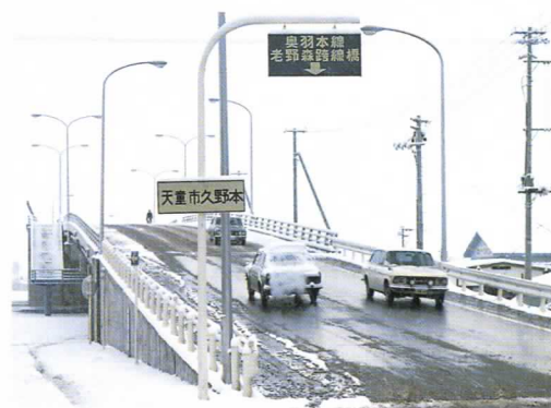
▲立体交差道路への敷設例
