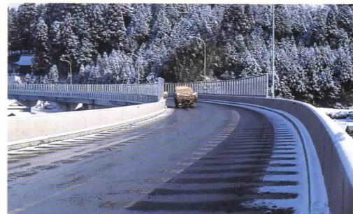
▲高速道路カーブへの敷設例
