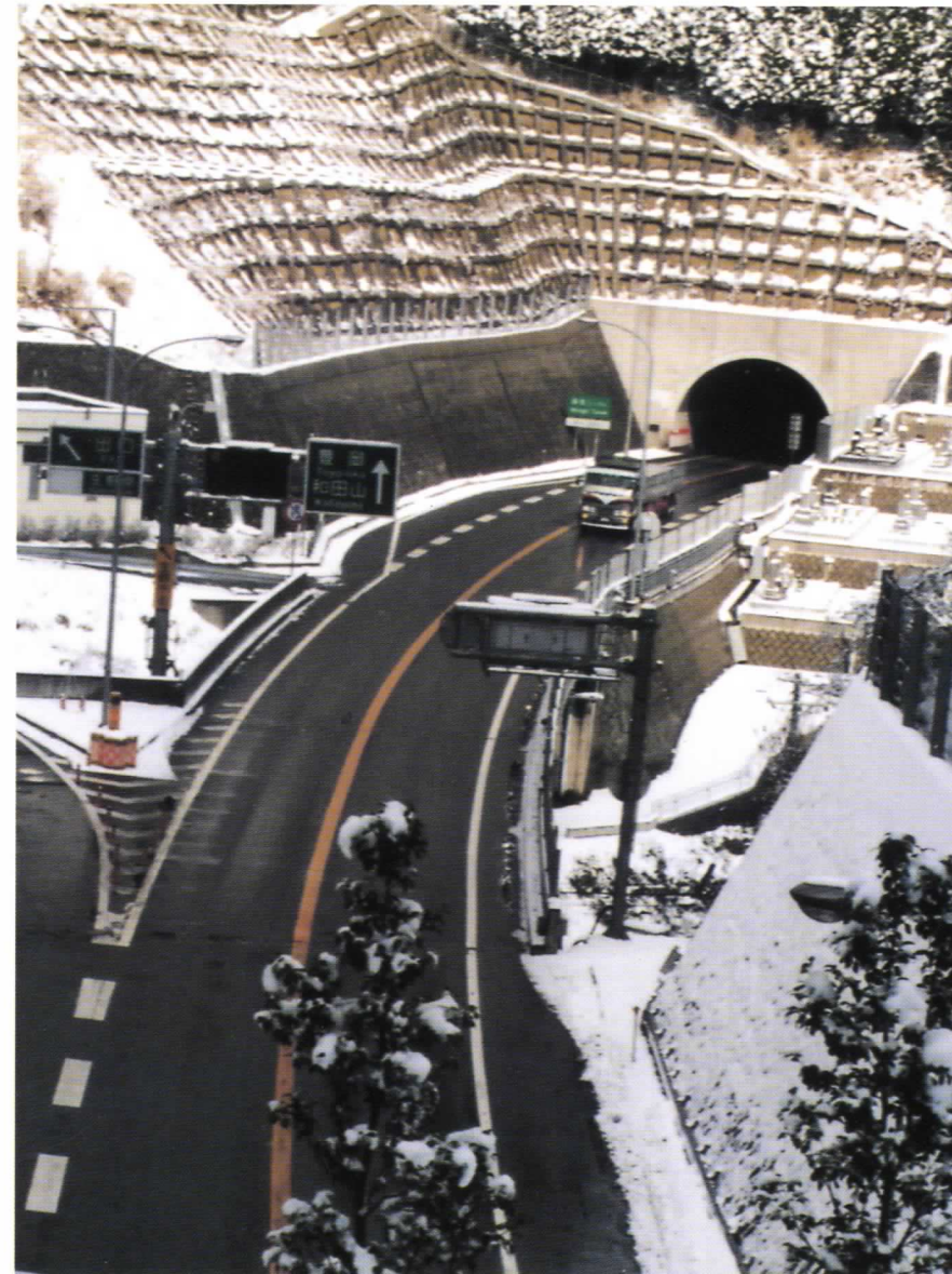
▲トンネル出口への敷設例
