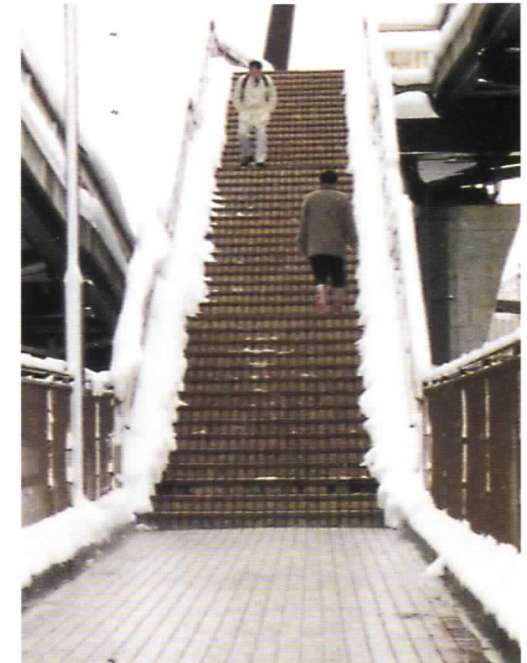
▲歩道橋への敷設例
