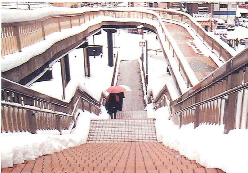
▲ペDESTリアンブリッジへの敷設例
