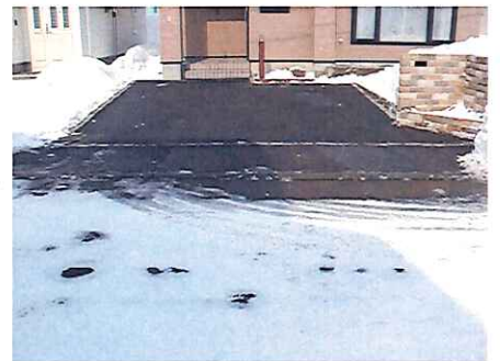
▲玄関前への敷設例
