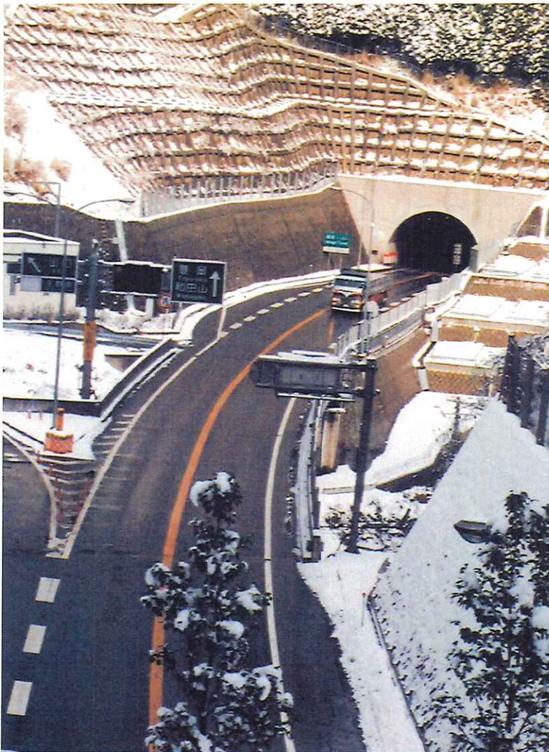
▲トンネル出口への敷設例
