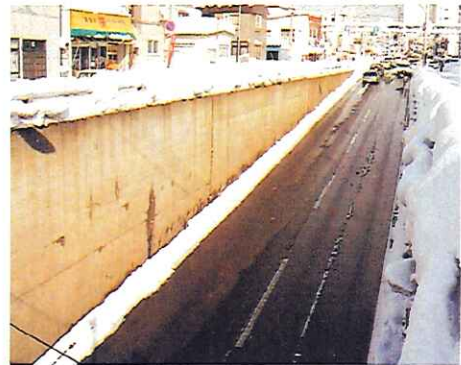
▲坂道への敷設例
