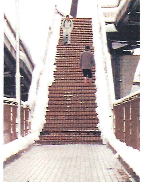
▲歩道橋への敷設例
