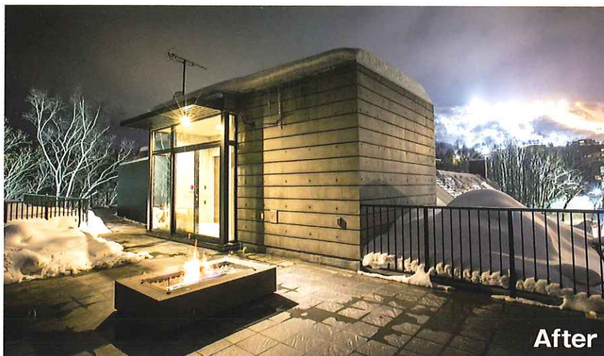
ニセコスキー場 施設屋上
