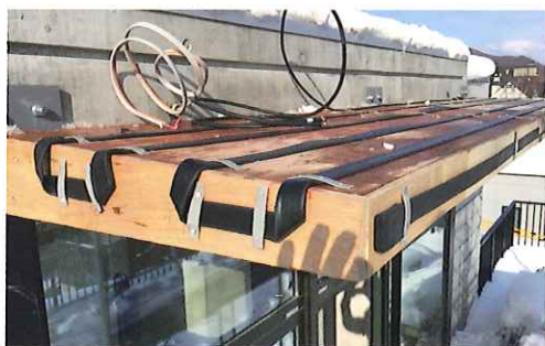
ひさし鋼板仕上げ前
