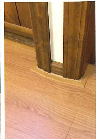
釘を使わず、置敷工法で仕上げます。
