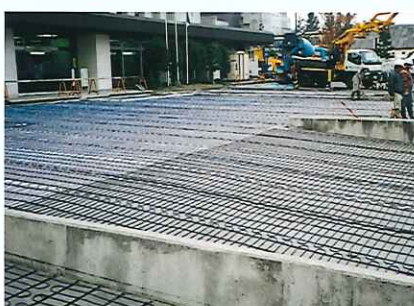
駐車場 ヒーティングユニット敷設
