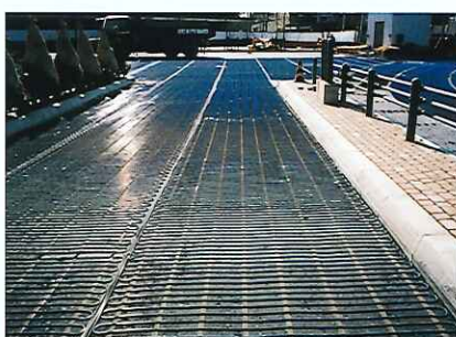
交差点 ヒーティングユニット敷設
