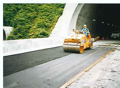
転圧作業状況
