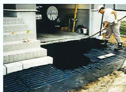
一般住宅・玄関 ヒーティングユニット敷設
