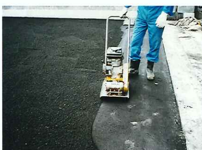
転圧作業状況
