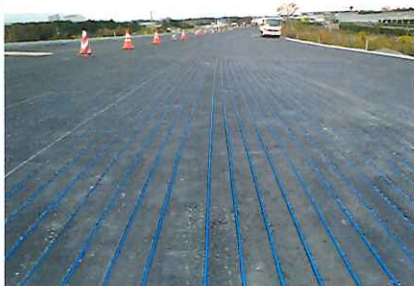
ヒーティングユニット敷設状況 (グルーピング工法)
