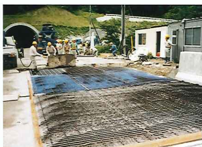
ヒーティングユニット敷設状況 (通常工法)
