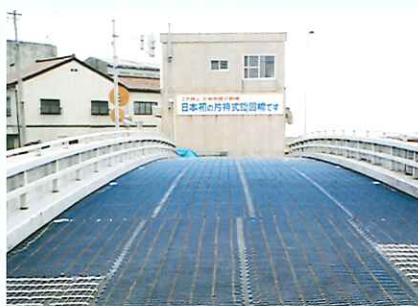
橋梁 ヒーティングユニット敷設
