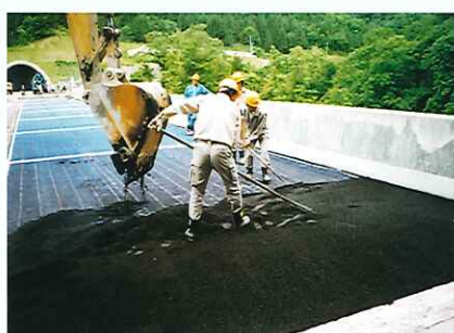
アスファルト舗設状況
