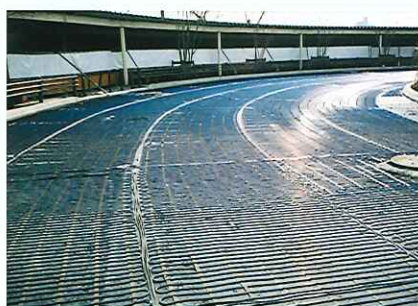
カーブ部 ヒーティングユニット敷設
