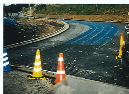
坂道 ヒーティングユニット敷設
