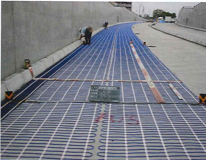
③ヒーティングケーブル敷設後
