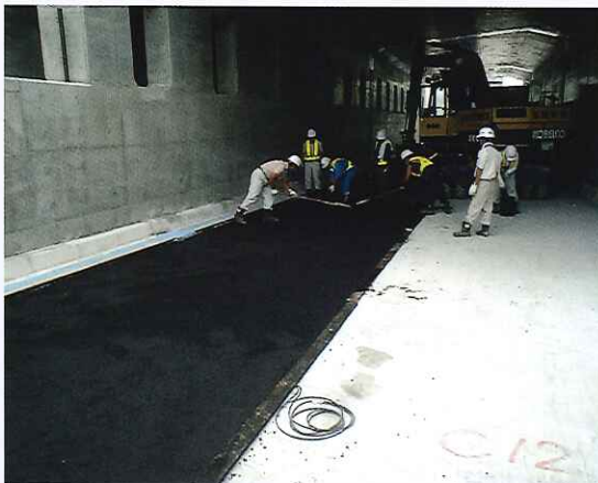
⑤アスファルト舗装後
