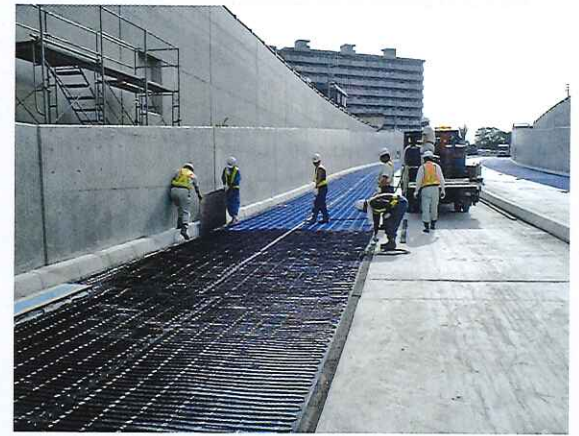
④アスファルト舗装前
