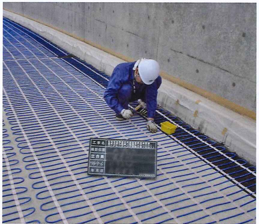
②ヒーティングケーブル敷設
